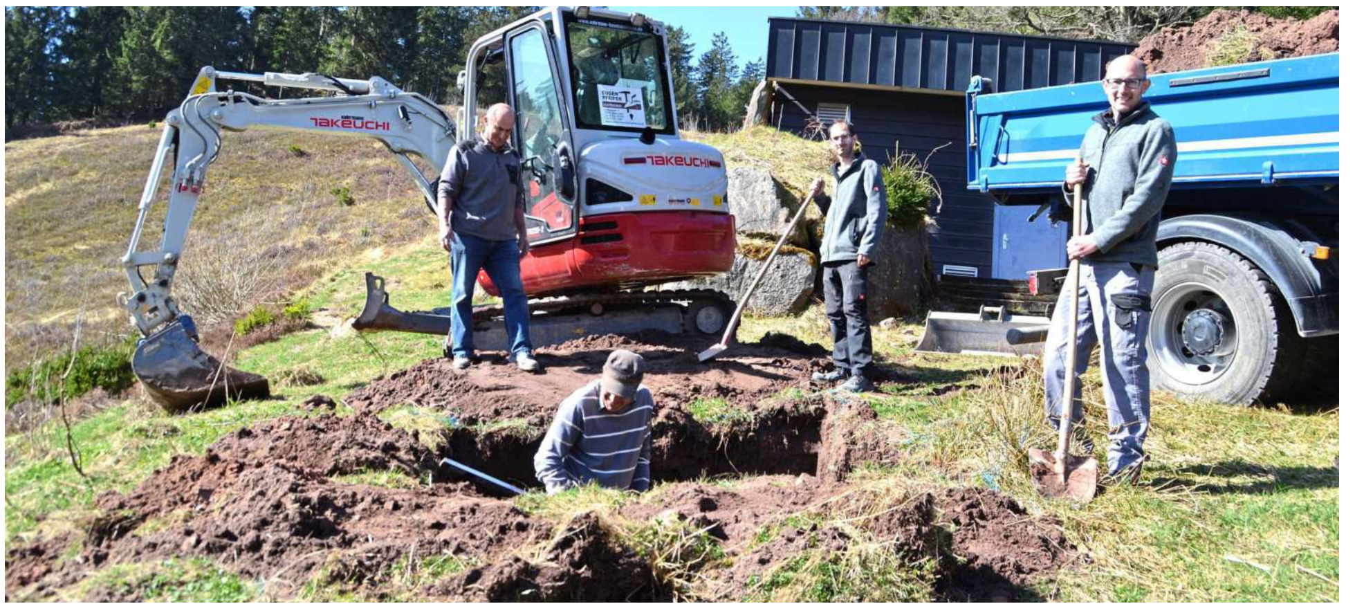
Mit großem Aufwand werden am Steilhang des ehemaligen Skigeländes Hundseck Fundamente für Fledermaus-Nistquartiere auf Stahltürmen ausgehoben. Foto: Geroald Hammes
