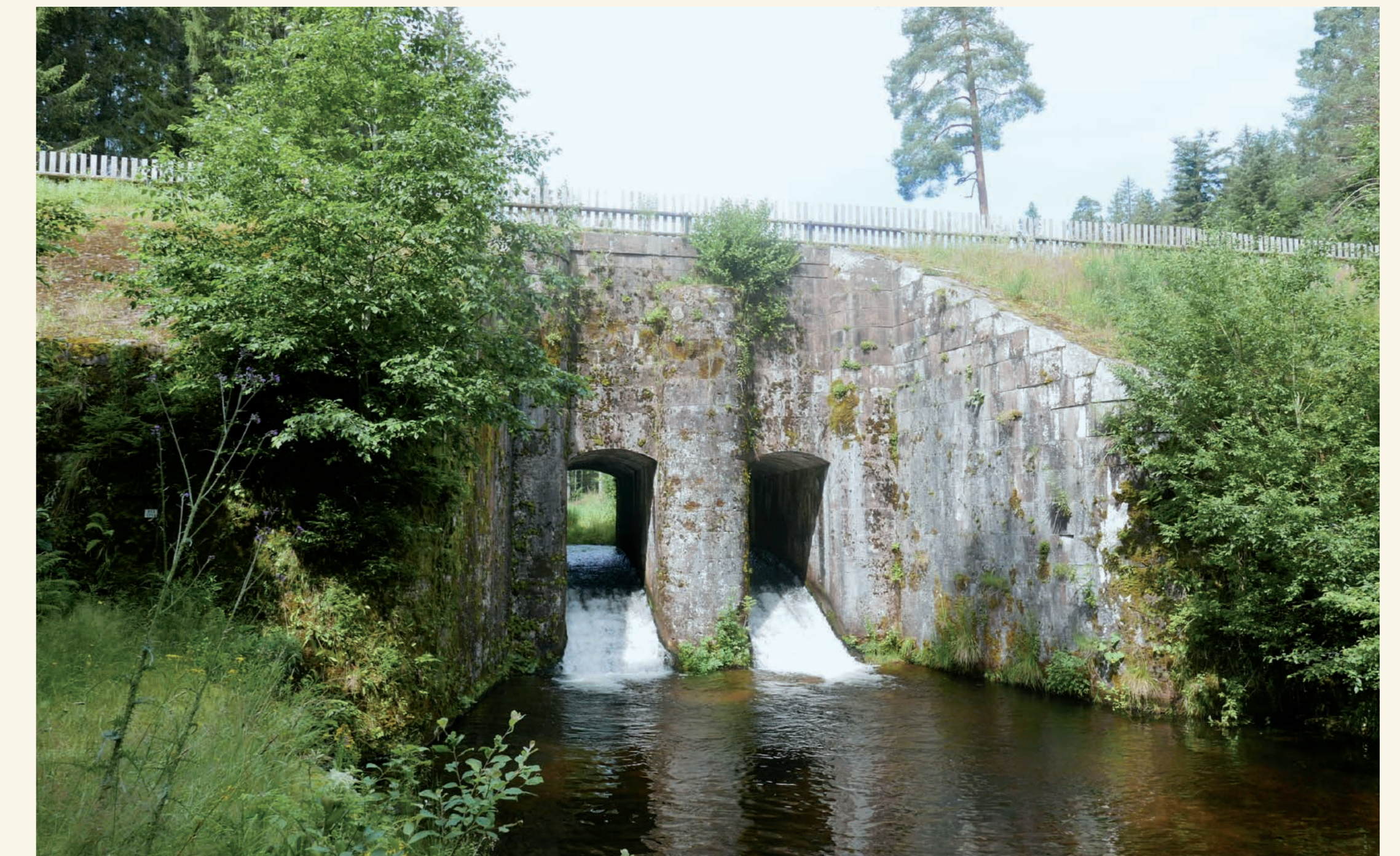
Die Herrenwieser Schwammung heute, die 1847 eine hölzerne Schwammung ersetzte.
