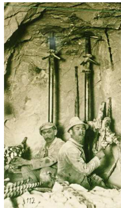
Im Hauptstollen: Ein rund 1,6 Kilometer langer Stollen wurde gebaut.
