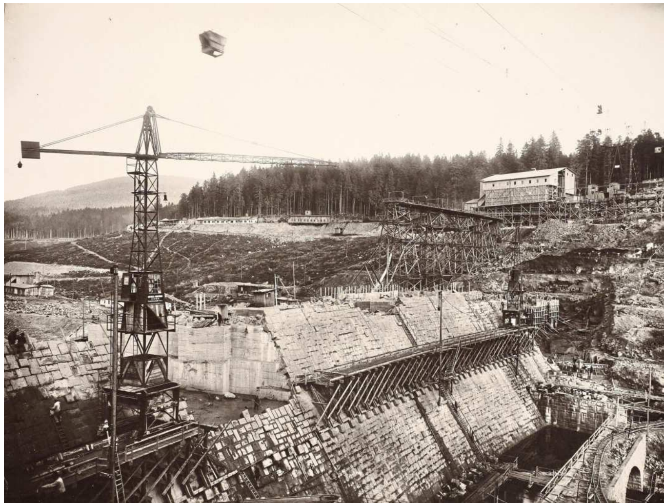
Großbaustelle: Im Oktober 1924 stand schon ein beträchtlicher Teil der Sperrmauer. Bei dem großen Gebäude im Hintergrund handelt es sich um die Brech- und Mahlanlage, das Baustoffversorgungs-zentrum. Fotos: Kreisarchiv Rastatt
