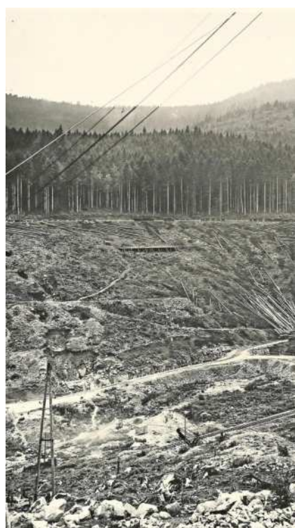
Kahlschlag: Die vorbereitenden Arbeiten für den Bau der Talsperre
